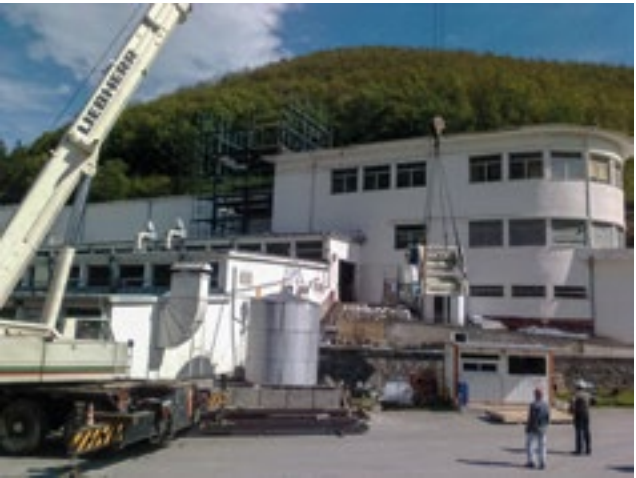
ВКАРВАНЕ НА ПРОИЗВОДСТВЕНОТО ОБОРУДВАНЕ НА ПЛ 4 ИЗТОЧНИК: ФИРМЕН АРХИВ
