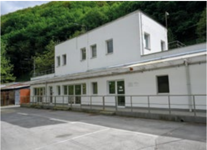
СГРАДАТА НА ПРЕЧИСТВАТЕЛНА СТАНЦИЯ ЗА ОТПАДЪЧНИ ВОДИ ИЗТОЧНИК: ФИРМЕН АРХИВ
