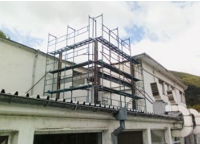
„КУЛАТА“ НА ПЪРВИЧНА ЛИНИЯ В ПРОЦЕС НА ИЗГРАЖДАНЕ ИЗТОЧНИК: ФИРМЕН АРХИВ
