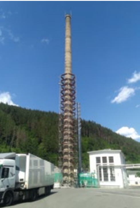
ЕТАП ОТ ПРЕМАХВАНЕТО НА СТАРИЯ КОМИН С ИНСТАЛИРАНО ОКОЛО НЕГО СКЕЛ. НА ЗАДЕН ПЛАН СЕ ВИЖДА ВЕЧЕ ИНСТАЛИРАНИЯТ НОВ КОМИН. ИЗТОЧНИК: ФИРМЕН АРХИВ
